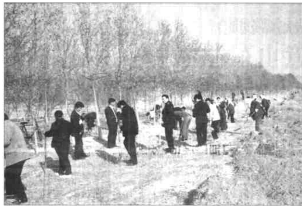
垦利县黄河口村新农村建设施工现场
